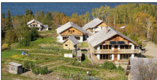
Figura 2: Ejemplos de construcciones mediante técnica de GREB.
