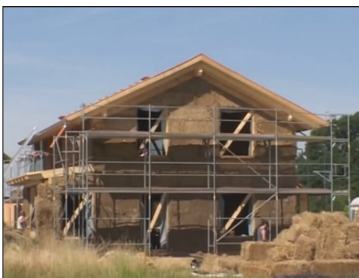
Figura 5: Detalle de proceso constructivo muros de cerramiento no portantes.
